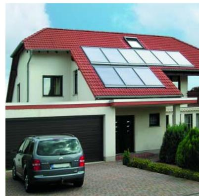
Collettore solare WTS-F1 integrato nel tetto
